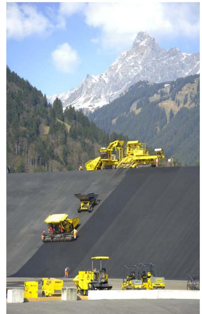
Im Zuge der Arbeiten am Rodundwerk II wird auch das Staubecken Latschau rundum erneuert.
