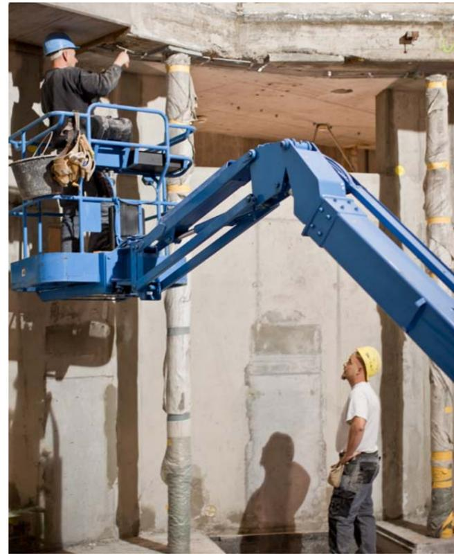
**Zwölftes Geschoß. Nein, nicht Obergeschoß – sondern Tiefgeschoß. Rund 50 Meter unter Grund steht man zunächst etwas unsicher. Da, wo sonst nie einer steht. Wo sonst Wasser den Raum im Druckschacht einnimmt und jetzt fleißige Arbeiter den Korrosionsschutz anbringen. Damit das Wasser zukünftig wieder die Pumpturbine des Rodundwerks II durchfluten kann.**
