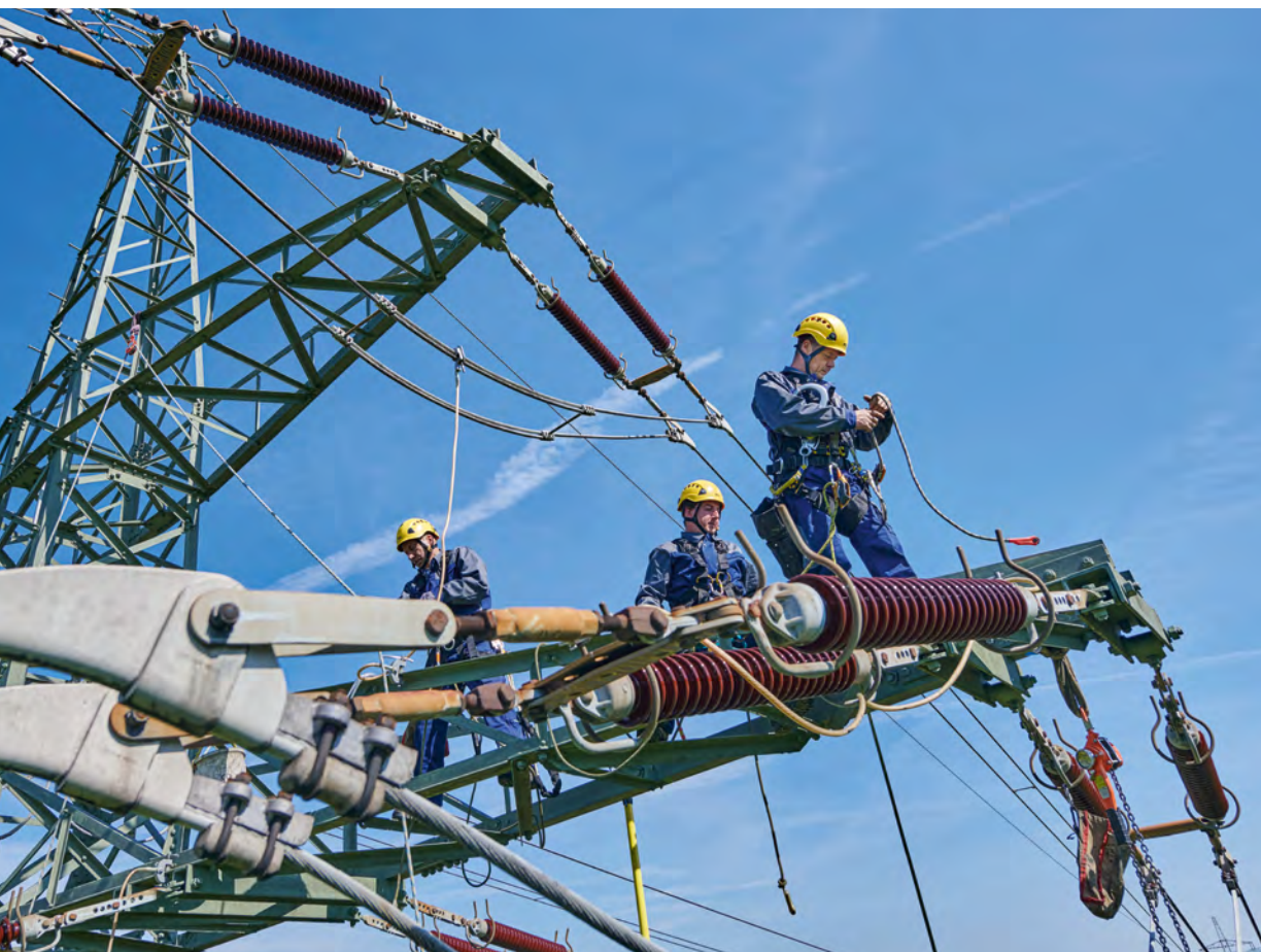
Montage eines Freileitungsmastes
